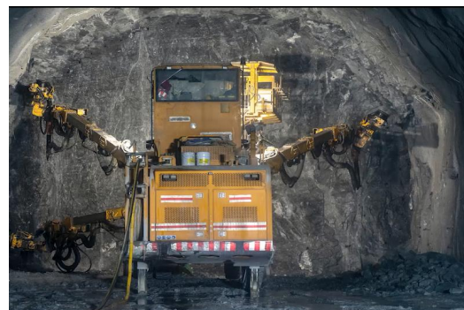
图 3-4 施工现场采用三臂凿岩台车开挖及锚杆钻孔
