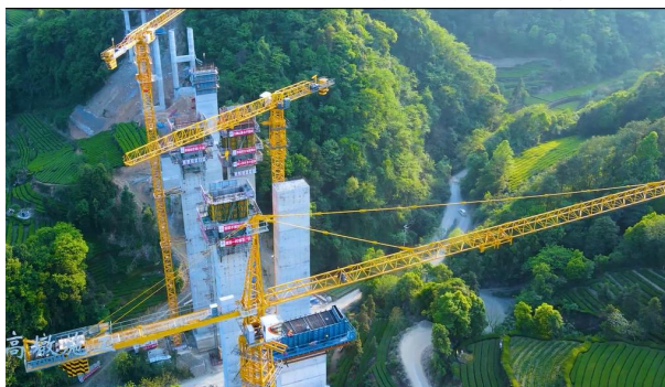
图 3-3 施工现场采用全自动液压爬模设备
